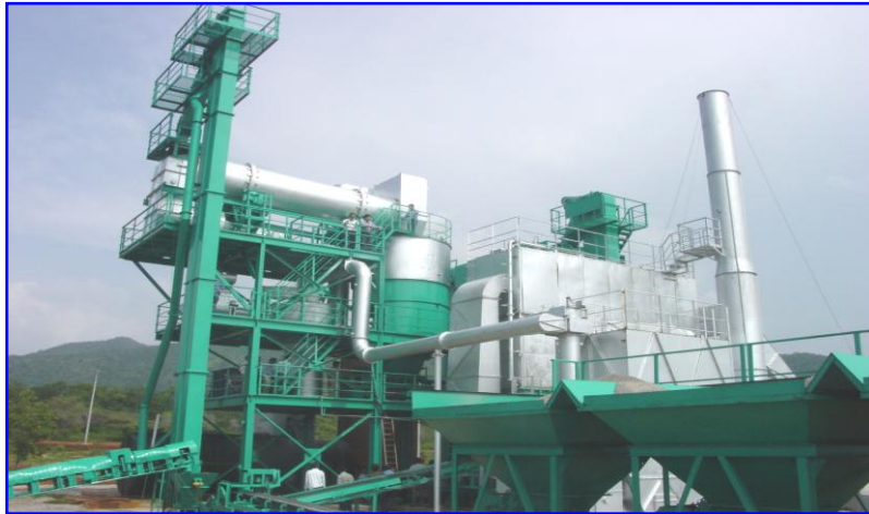
รูปที่ 5 Central Plant แบบ Batch Plant สำหรับผสมวัสดุ Hot Mix Recycling โดยเฉพาะ
