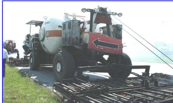
รูปที่ 8 เครื่อง Pre-heater
